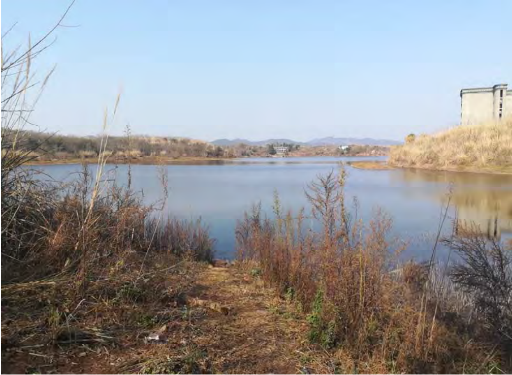
赤水分干渠取水口
