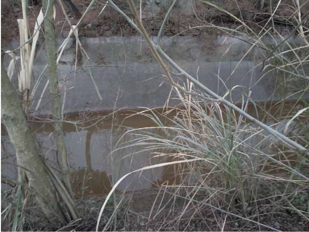
低太平分干渠渠道
