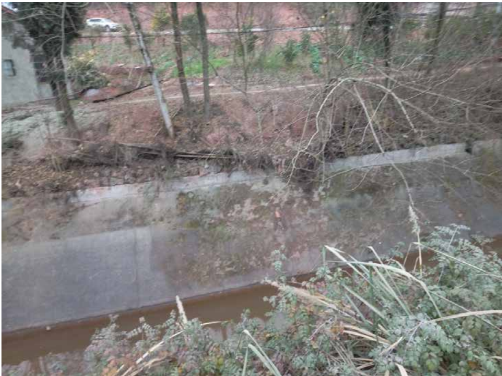
低太平分干渠渠道
