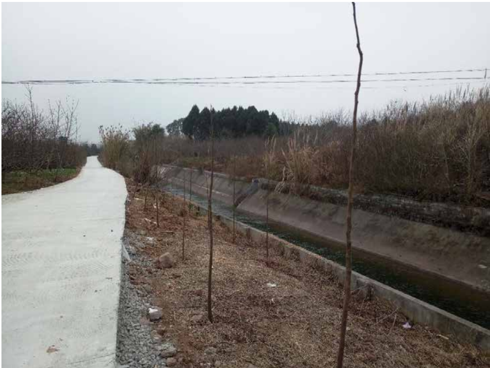
玉成分干渠渠道
