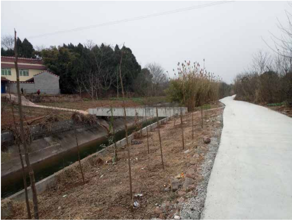
玉成分干渠渠道
