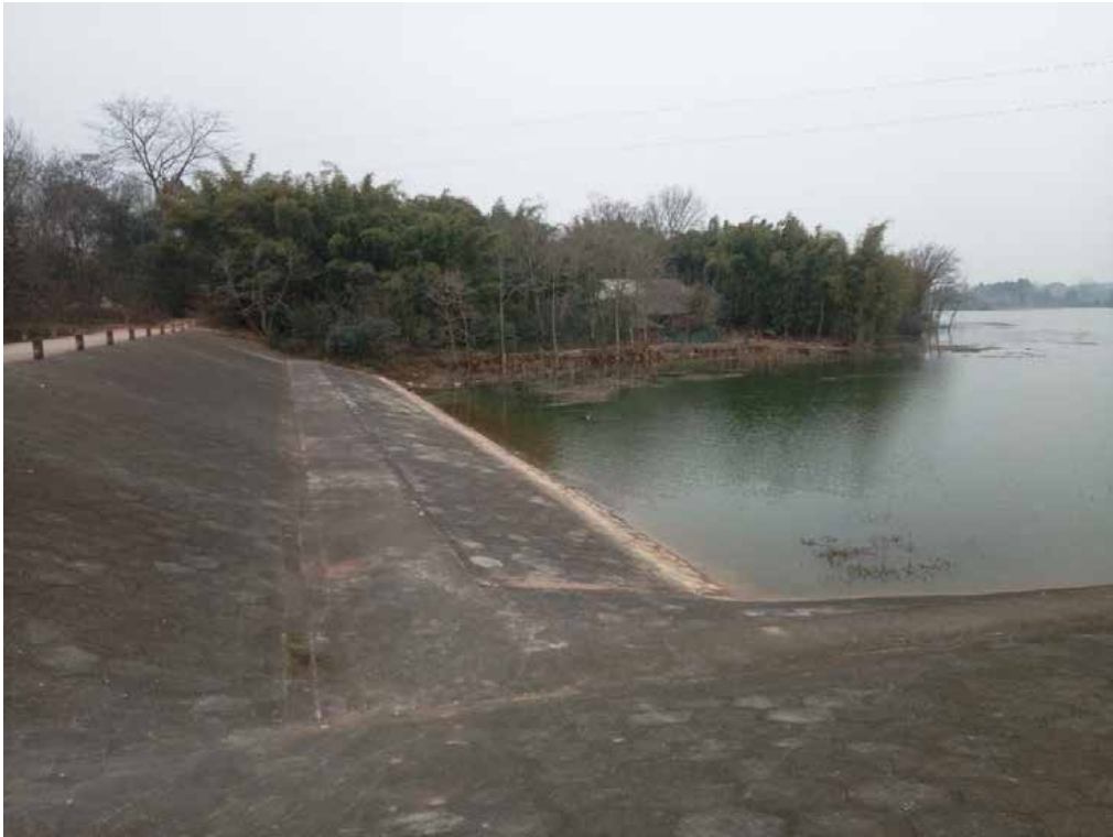
玉成分干渠取水口
